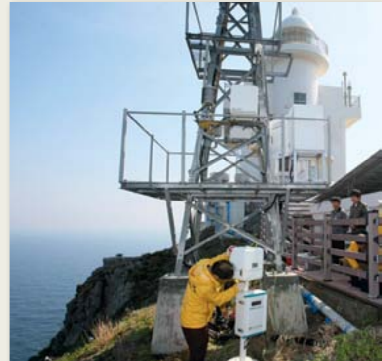
▲ 독도에 설치된 등대와 방사능 감지기
