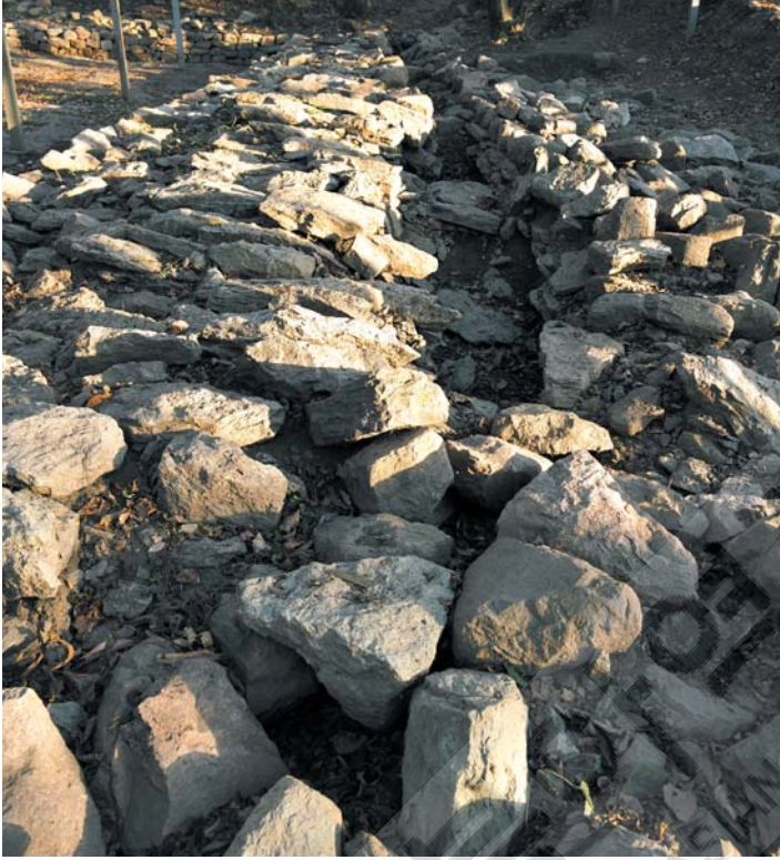
오녀산성 대형 건물지와 온돌 시설
